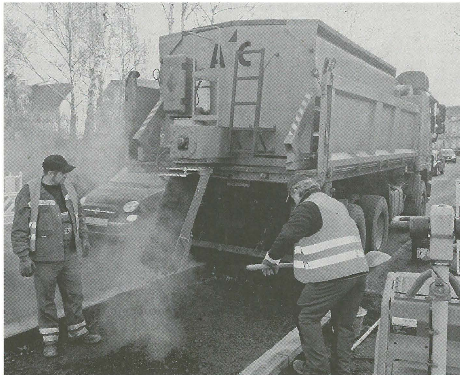
Saubere und sichere Asphalttierung eines Randstreifens in Innenstadtlage.
