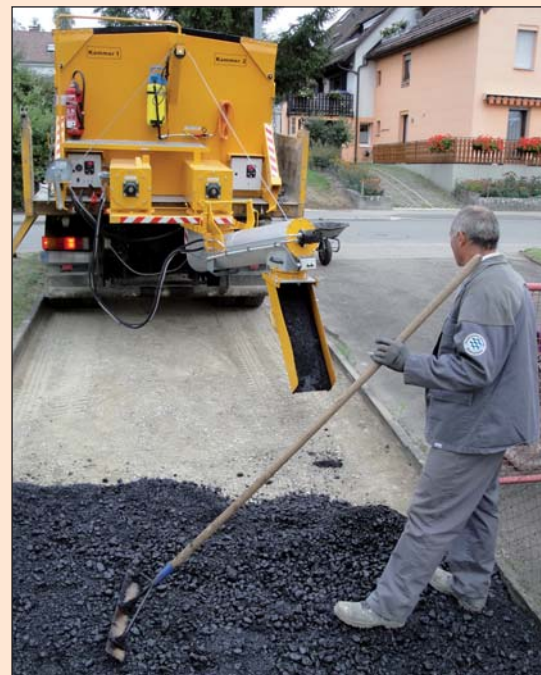
▶ ATC 75K/2 à deux chambres avec transporteur à vis sans fin externe
