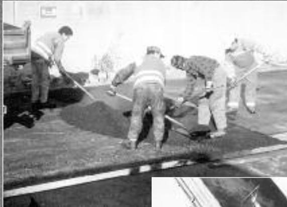
Scarico manuale del camion con elevati costi di manodopera e faticosa pulizia della superficie di carico.
