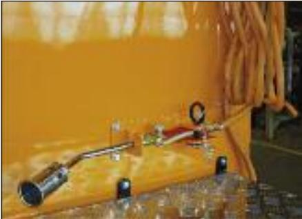
Il bruciatore a gas esterno con allacciamento del gas supplementare sul container è sempre pronto per l'uso per i lavori secondari, come la fusione della mano di attacco di bitume o la pulizia degli strumenti di lavoro. Così il trasporto di una bombola del gas supplementare diventa superfluo.
